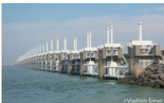
「東スヘルデ防潮水門」は、長さ9kmの巨大な水門式のダム
